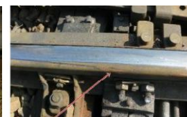
Foto 4 - locul căderii roții partea dreaptă sens mers a osiei nr.5
