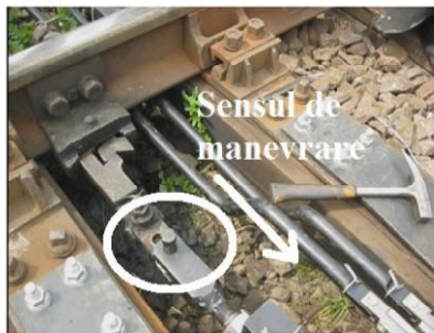
Foto nr.49- manevrarea din poziția intermediară către poziția de „PLUS”. bara de tracțiune se depărtează de bara de acționare și bolțul începe să coboare
