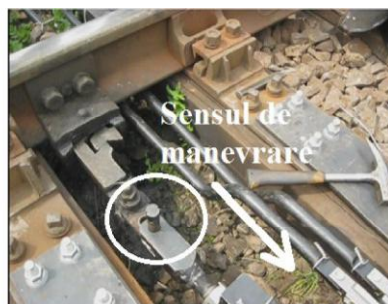
Foto nr.48- manevrarea din poziția intermediară către poziția de „PLUS”, bolțul este încă în partea superioară a furcii barei de tracțiune
