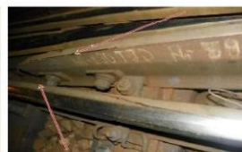
Foto 2 - locul căderii roții partea dreaptă a osiei nr.6 și lovirea contrașinei inimii duble
