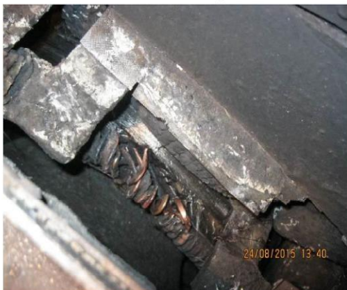
Foto nr.2 – spirele bobinajului rotorului al motorului de tracțiune nr.4
