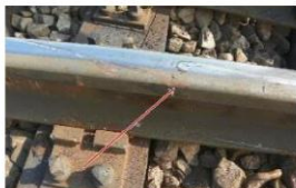
Foto 8 - locul căderii roții partea dreaptă în sensul de mers a osiei nr.3
