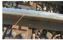
Foto 10 - locul căderii roții partea dreaptă în sensul demers a osiei nr.2
