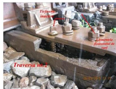
Foto nr.46 – Prinderea (tirfoane inactiv) la traversa nr.2
