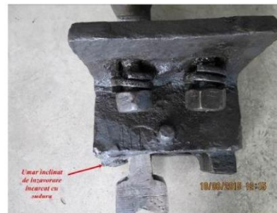
Foto nr.42- Caseta de înzăvorăre de la fixătorul de mijloc partea stângă în sensul de mers tren, montată pe contraacul curb (înzăvorăre ac drept) lângă o casetă de înzăvorăre nouă
