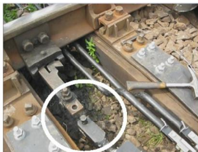
Foto nr.50- bolțul a căzut complet în orificiul din bara de tracțiune iar bara de tracțiune a căzut spre sol
