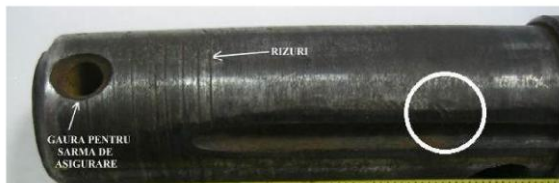
Foto nr.26 – Bolțul de la schimbătorul de cale nr.7
