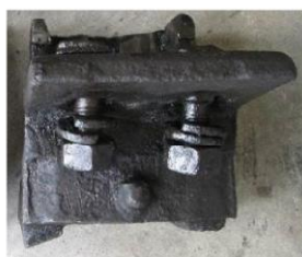
Caseta de înzăvorăre fixător de mijloc, montată pe contraacul curb (înzăvorăre ac drept) Foto nr.39
