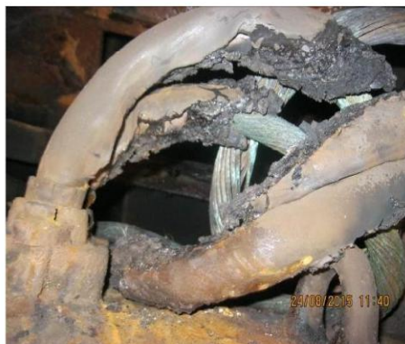
Foto nr.4 – cablurile de alimentare afectate termic
