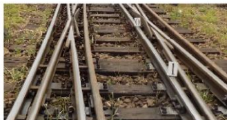
Foto 13 – detaliu cu punctele „-1” și „-0”, situate pe curba TJD nr.15/17, cu raza R=190 m
