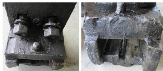
Caseta de înzăvorăre fixator de vârf, montată pe contraacul curb (inzăvorăre ac drept) Foto nr.37
