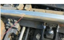
Foto 6 - locul căderii a roții din partea dreaptă în sensul de mers a osiei nr.4
