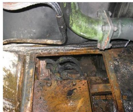
Foto nr.1 – zona MT 4 unde s-a produs incendiul
