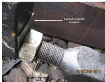
Foto nr.29 – Siguranța piuliței speciale a barei de tracțiune de la schimbătorul de cale nr.7
