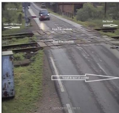
Foto nr.2 - Situația pe teren înainte de producerea accidentului, cu parcurșul de trecere asigurat pe firul II de circulație - instalația SAT în funcție
